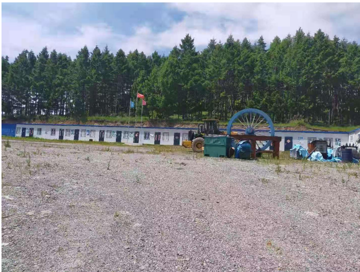
照片 1-1 建设中工业广场（临时办公区）
