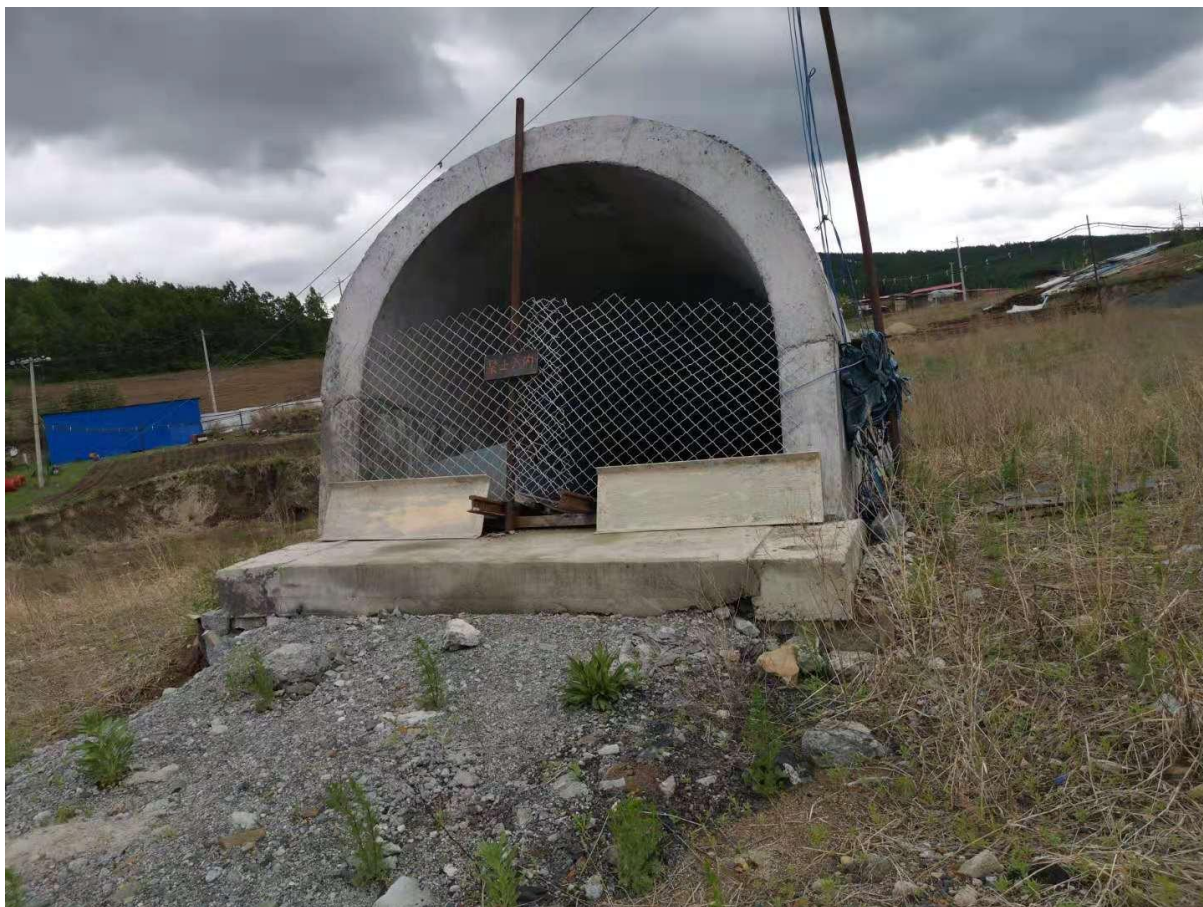
照片 1-2 建设中主井
