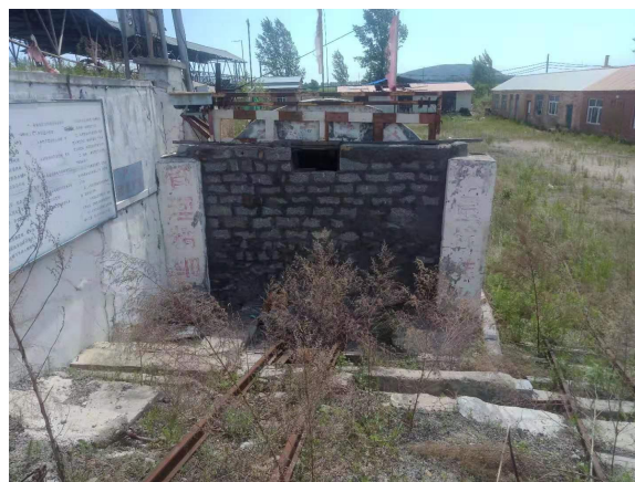
照片 1-2 临时封闭井口（原有主井）
