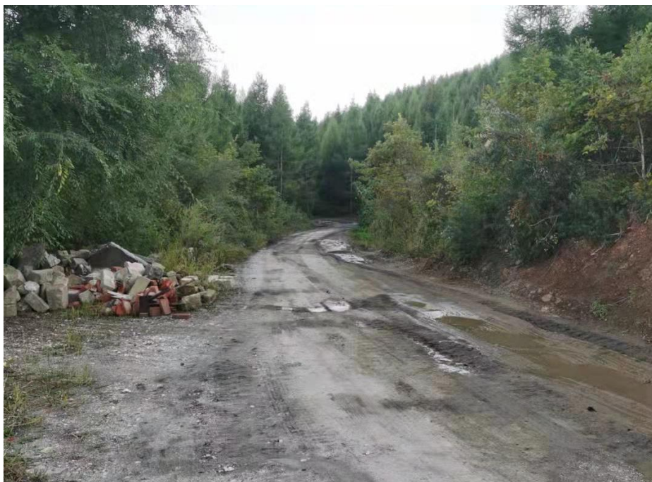
照片 3-3 通矿道路
