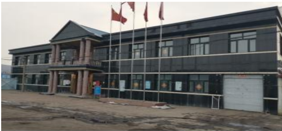
图 1-5 工业广场现状照片
