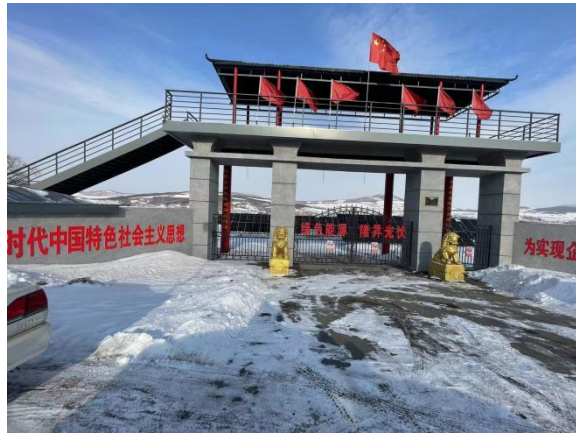
厂区东侧-光伏发电站
