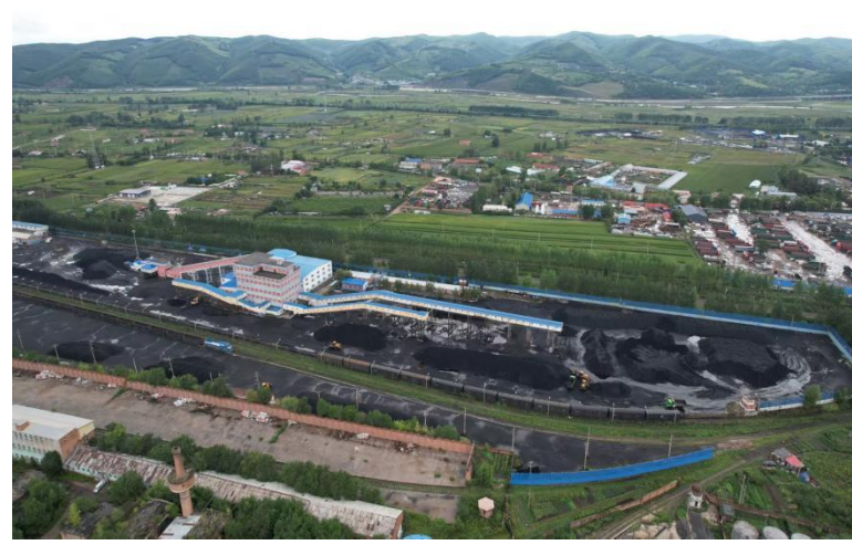
厂区北侧洗煤厂及空地
