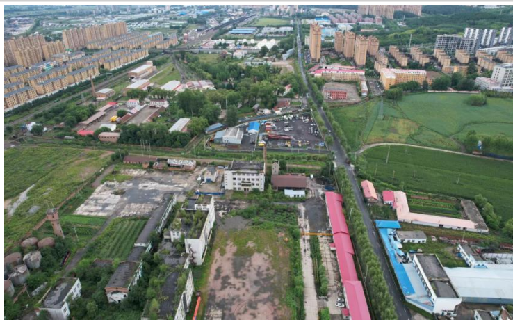
厂区东侧闲置建筑及场地
