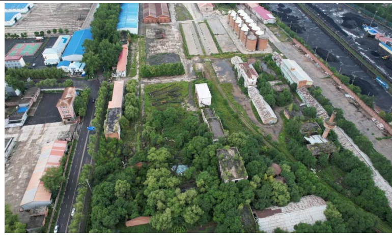
厂区西侧闲置建筑及场地
