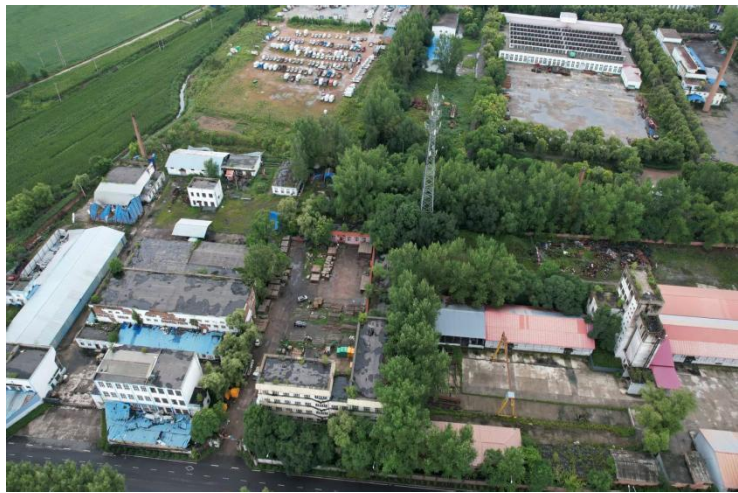
厂区南侧铁西街、闲置建筑及场地
