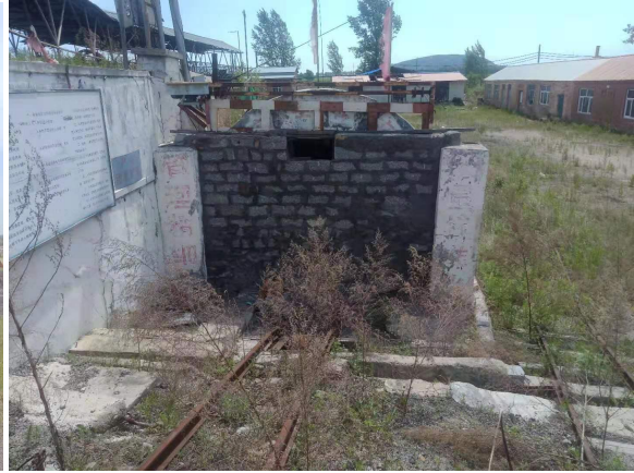
照片 1-2 临时封闭井口（原有主井）
