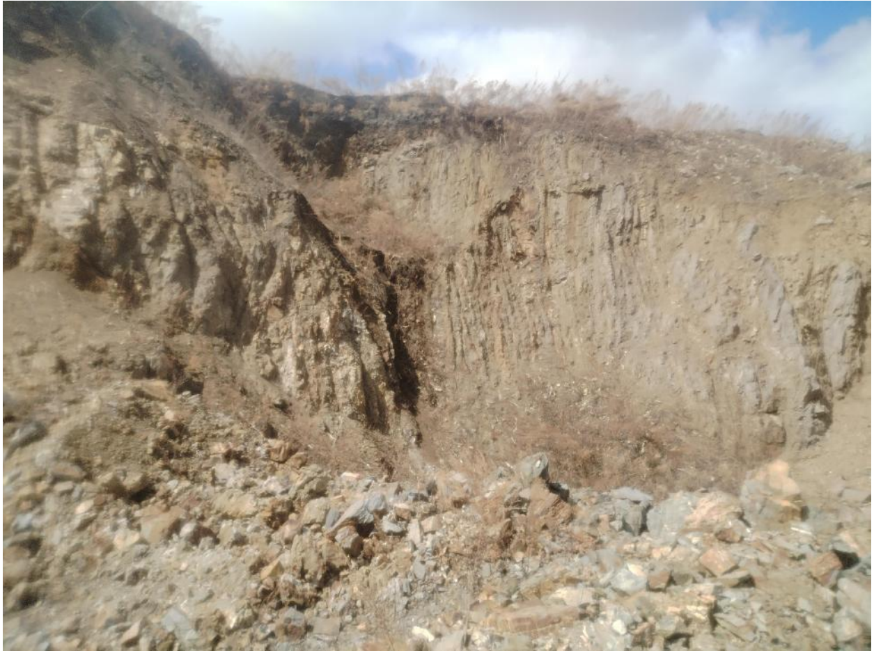
照片 3-1 崩塌地质灾害现状照片
