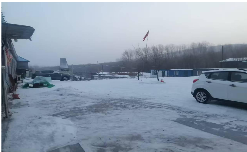
图 3-2 工业广场现状照片
