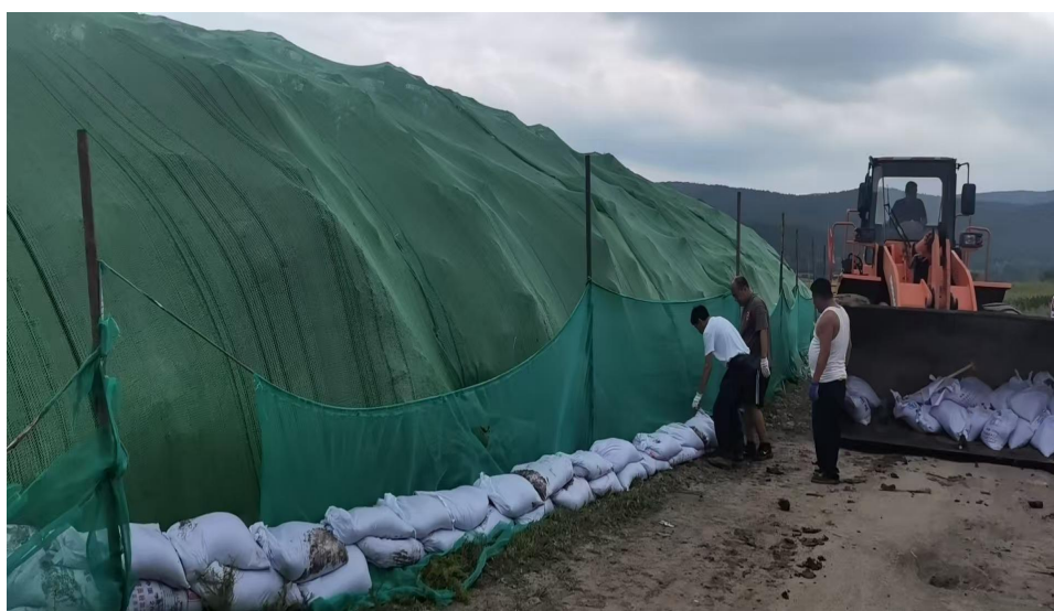
图 4-1 矿区临时排土场照片
