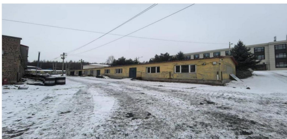
图 3-4 工业广场现状照片
